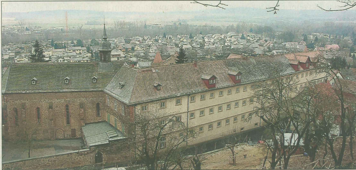
Das Gebäude zeugt noch davon, wie viele Schwestern hier einst untergebracht waren: Das Ursulinenkloster in Fritzlar, links die dazugehörige Kapelle. Fotos: Dellit
